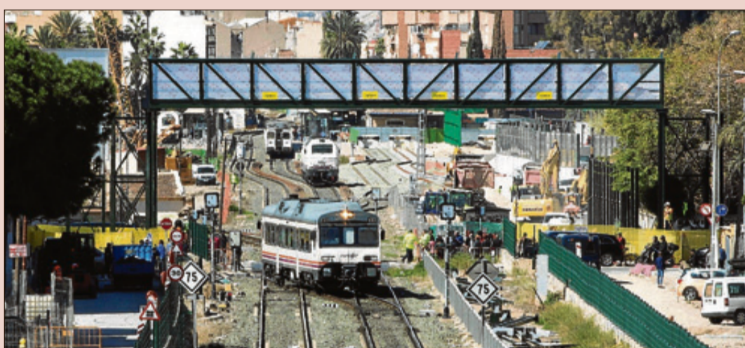
Las obras del soterramiento siguen y la última incorporación ha sido la pasarela peatonal. JUAN CABALLERO
