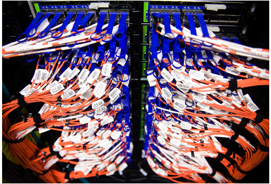
A baix, detall d'un rac de connexions del Mareostrum. Aquesta infraestructura requereix quasi 100 quilòmetres de cable per funcionar. A l'esquerra, els investigadors del departament de Ciències de la Vida del BSC han desenvolupat un programari per descobrir nous medicaments a través de complexes simulacions informàtiques.
